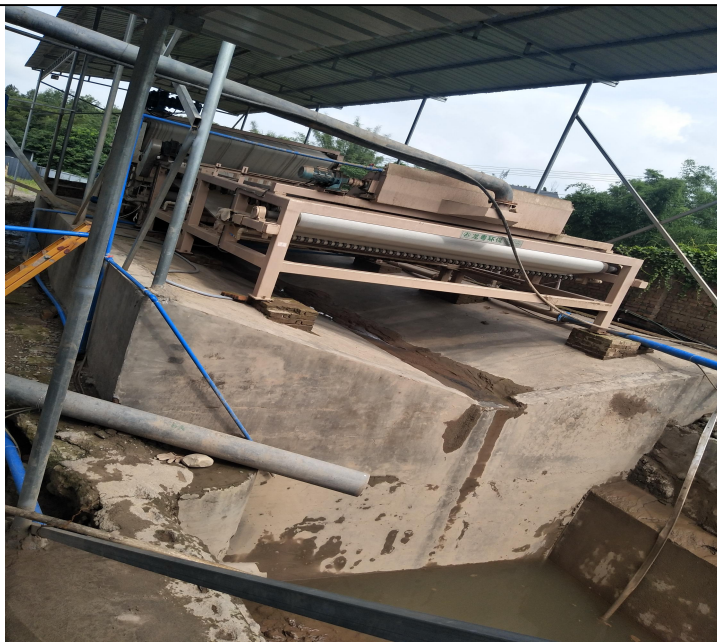
图 3-6：带式压泥机
