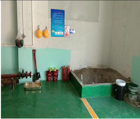
图 5: 消防砂池及捡漏托盘
