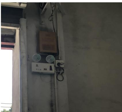
图 9: 可燃气体泄漏报警装置
