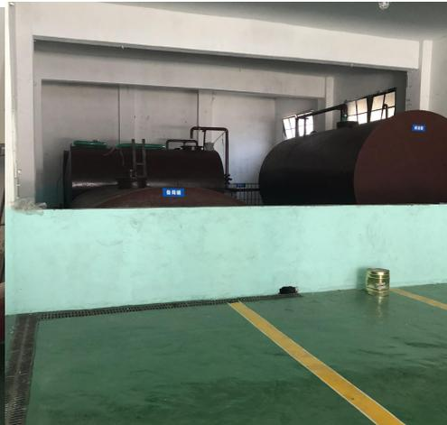
图 4：防火堤及围堰
