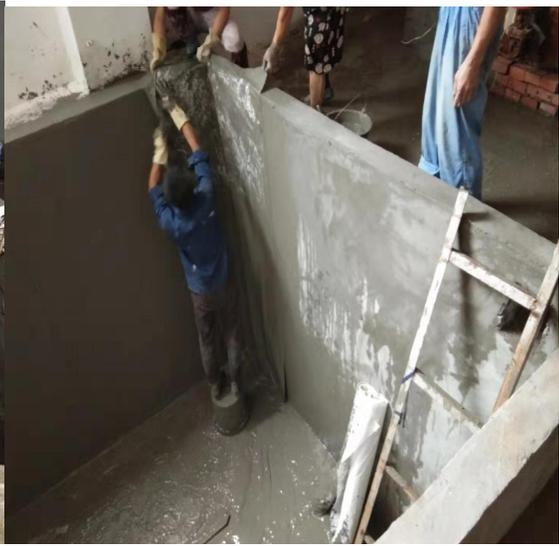
图 12：应急池防渗施工图片
