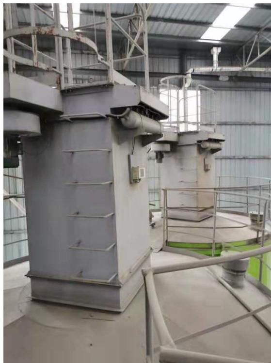
图 3-6 粉料仓顶除尘器
